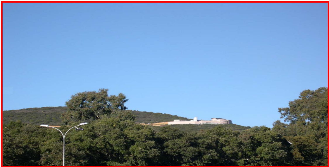
La station de traitement des Eaux de la Confina, qui alimente en partie la commune.
